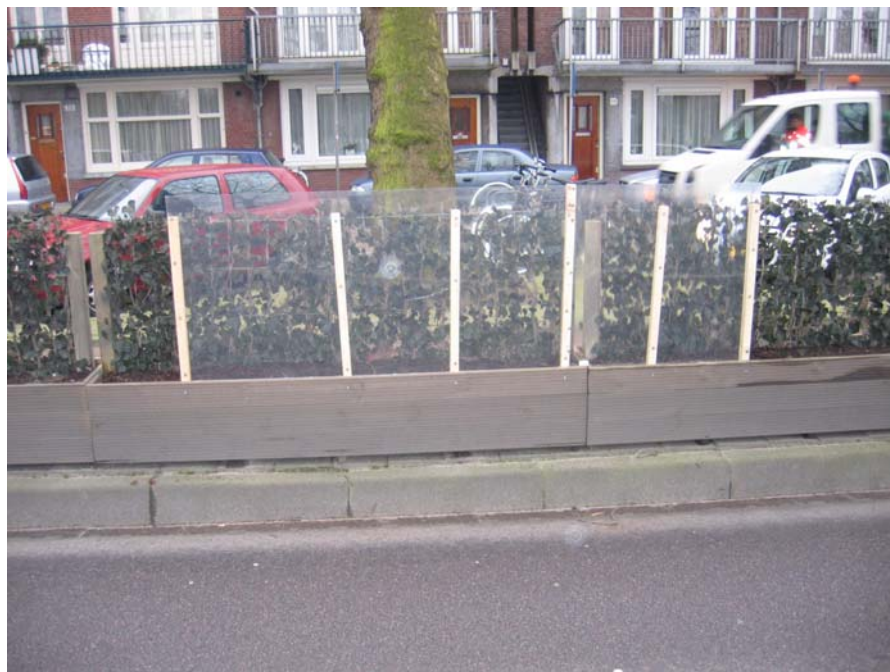
Figuur 16b Plexiglasscherm van 1.5 m hoogte voor een gedeelte van de haag.
